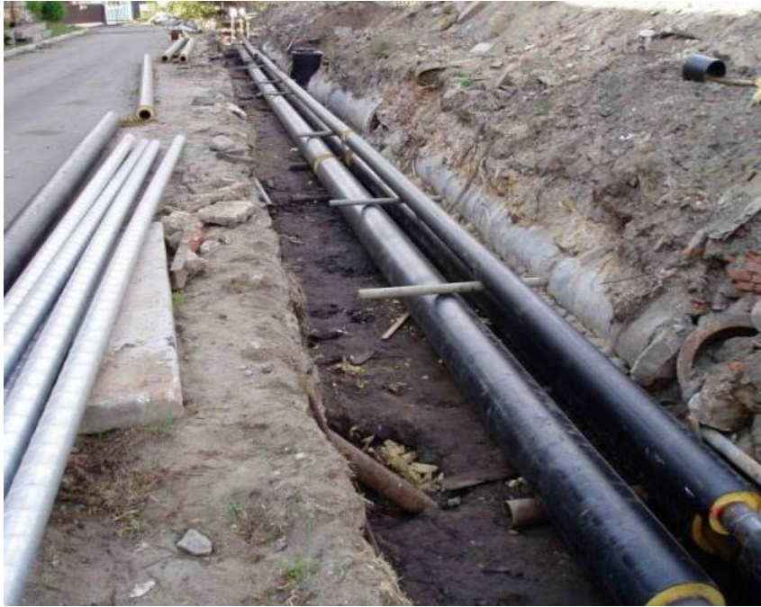
Фото 1. Укладка линейного участка подземного газопровода
